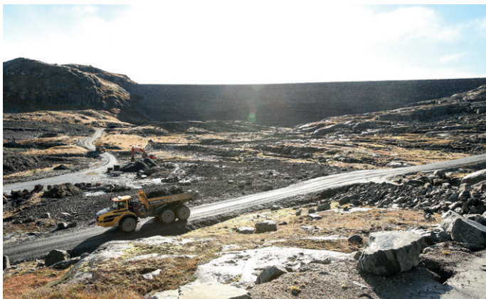
Store anleggsmaskiner har vært i sving med sikringen av Nyhellervatn kraftdam.
