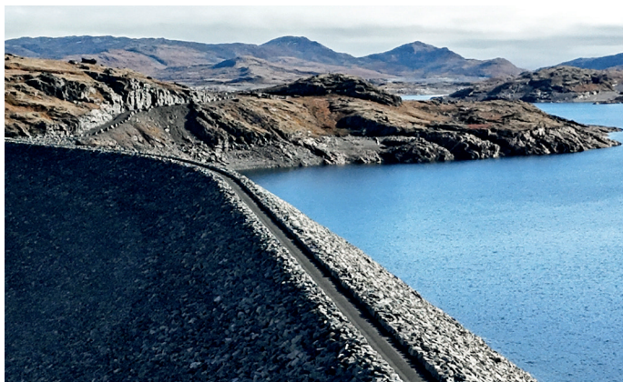
Nyhellermagasinet sett fra vest. Entreprenør Tore Løkke As har jobbet seg platå for platå fra bunnen og oppover.
