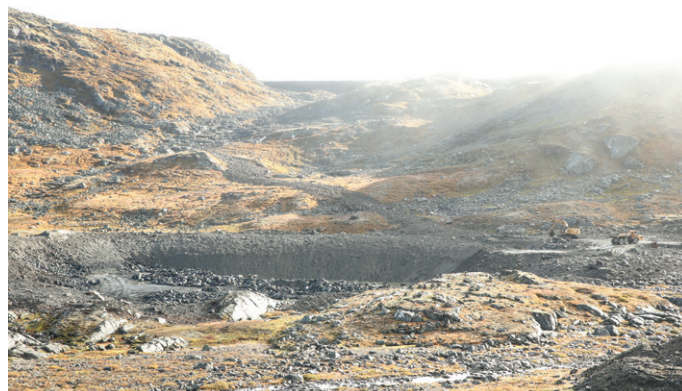
Dagbruddet nede, under demningen. All masse brukt i prosjektet er hentet ut fra dette dagbruddet og et tilsvarende i magasinet.
