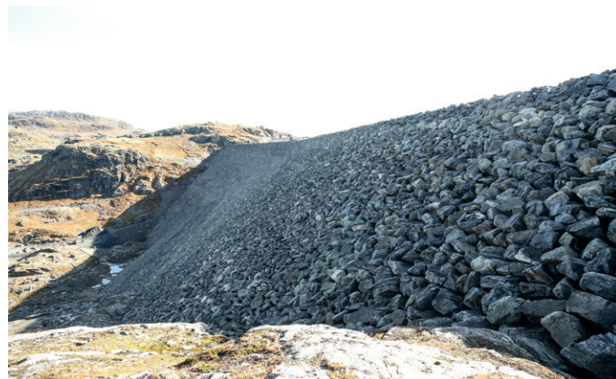
Sikringsarbeidet er utført med et indre sjikt med støttefylling av samfengt sprengstein, sjikt to er bygget av blokker uten finstoff slik at det ikke skal kunne passere ut gjennom hulrom i plastringen i det ytre sjiktet.
