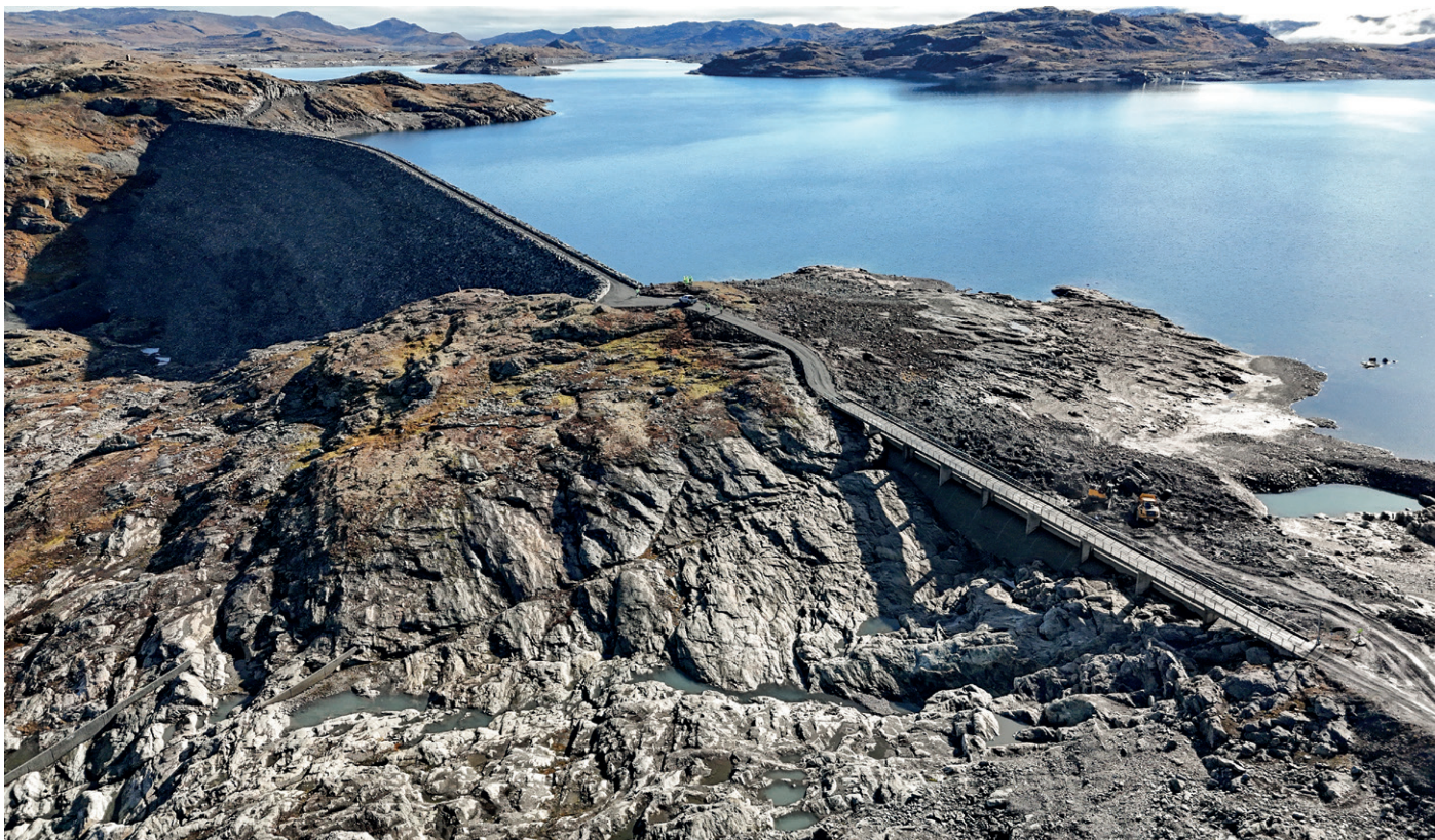
Nyhellermagasinet sett fra vest. Hovedprosjektet til nesten 300 millioner kroner før moms har vært å sikre den 650 meter lange og 84 meter høye demningen til venstre.
